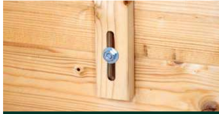
Sturmleiste bei Wandstärken 28, 40 und 44 mm
