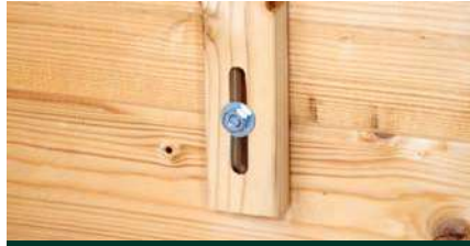
Sturmleiste bei Wandstärken 28 und 40 mm
