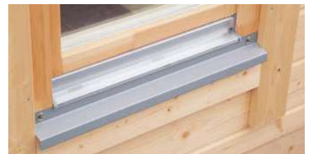
Fenster mit Metall-Fensterbank
