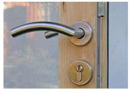
Edelstahl-Türbeschlag und Zylinderschloss
