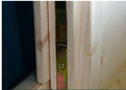
Eingelassener Tür- bzw. Fensterfeststeller
