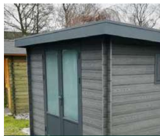
28 mm Wandstärke: Aluminium-Dachkranz
