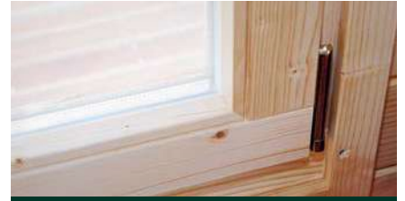
Isolierverglasung ab 34 mm Wandstärke
