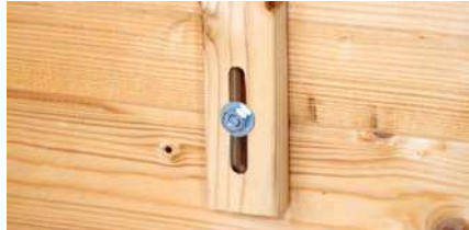
Sturmleiste bei Wandstärken 28 und 40 mm
