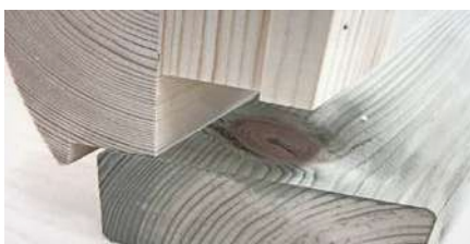
Wandelement auf imprägnierten Rahmen
