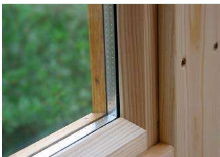
Isolierverglaste Leimholz-Fenster
